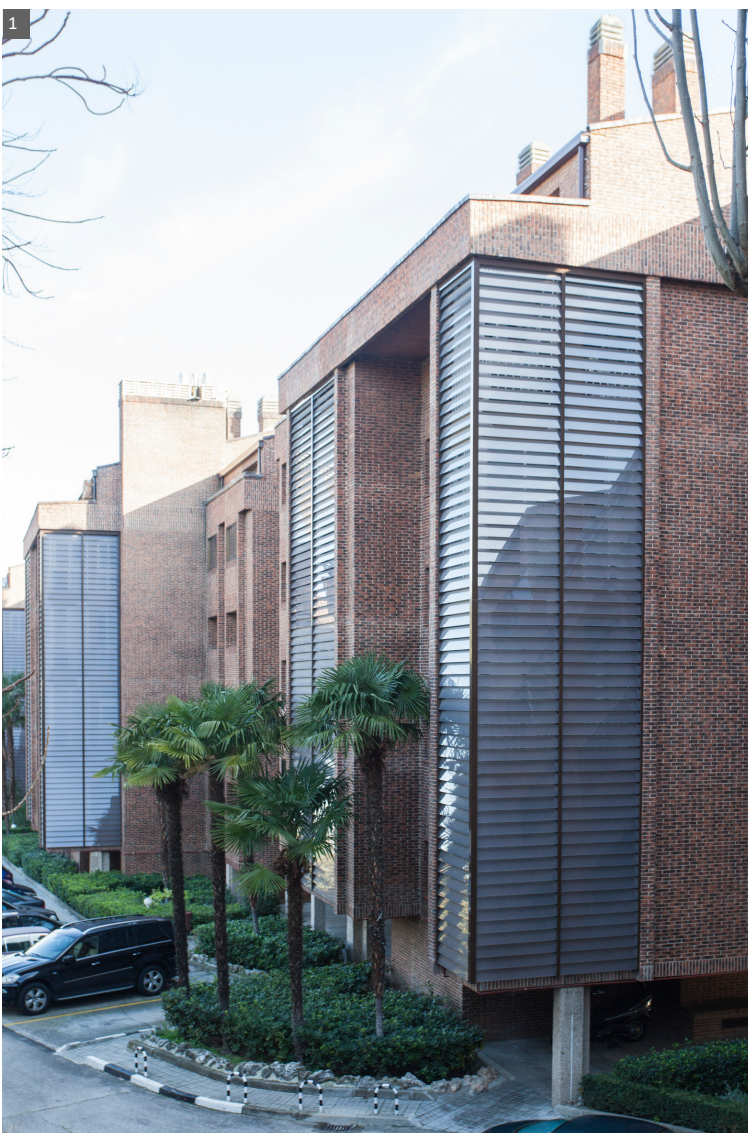
1. Rehabilitación de las celosías fachada en el espacio de tendederos / La Moraleja, Madrid / uin2.vf
