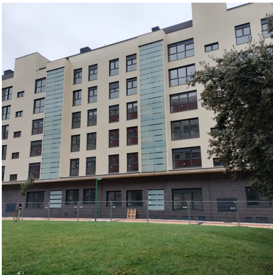
1. Viviendas / Burgos /ACR constructora / uin2.vf
